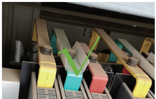
增加绝缘帽和绝缘隔板
