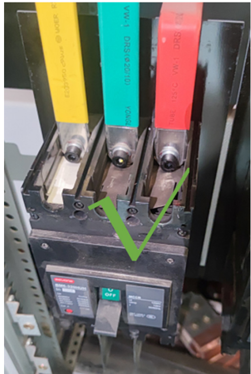
喷弧口纸片吹开及少许金属例子残留
