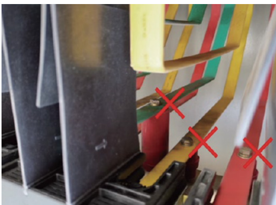
铜排有裸露带电螺钉
